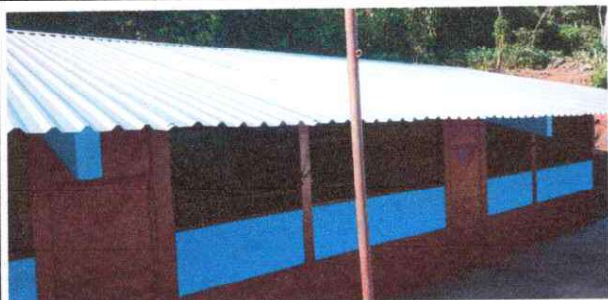
foto 1: Sustrucción de lámina, por lámina troquelada aluzinc calibre 26, en aula y dirección.
