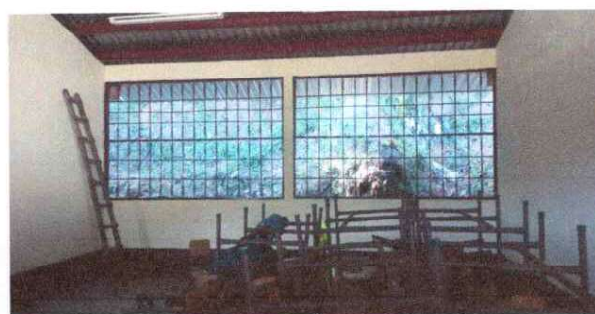
FOTO 4: mantenimiento a valones de metal, en aula y dirección.
