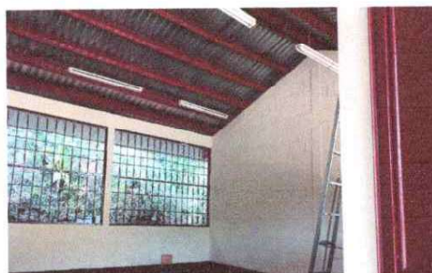
FOTO 2: Sustrucción de estructura de soporte de metal por metal, en aulas y dirección.
